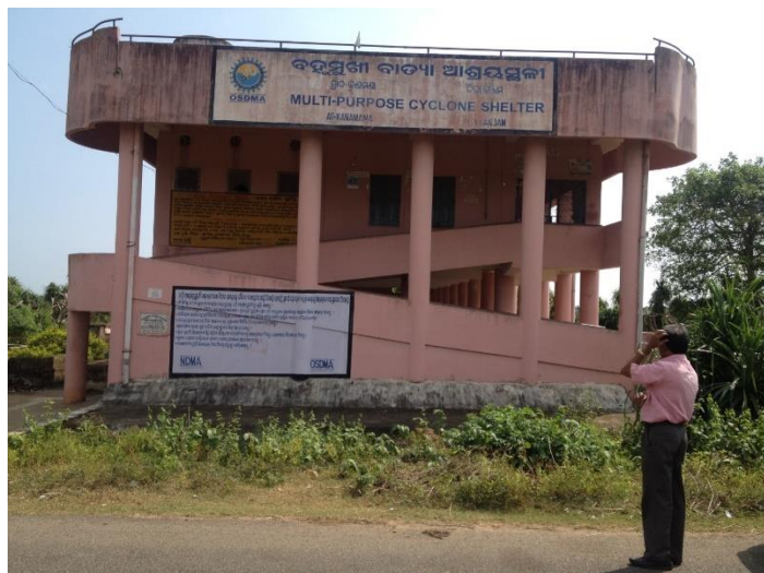
« Multi-purpose cyclone shelter »
